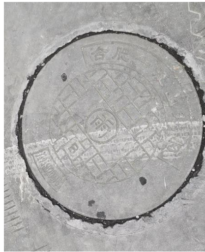
图 3-5 厂区雨水总排口
